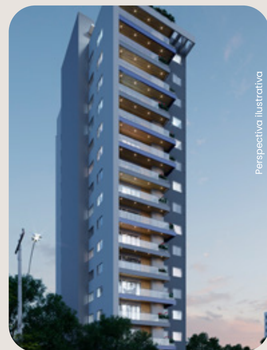
Ed. Residencial Vereda Estrela Sul I Rua Pétila Misteriosa, 25, Estrela Sul - Juiz de Fora
